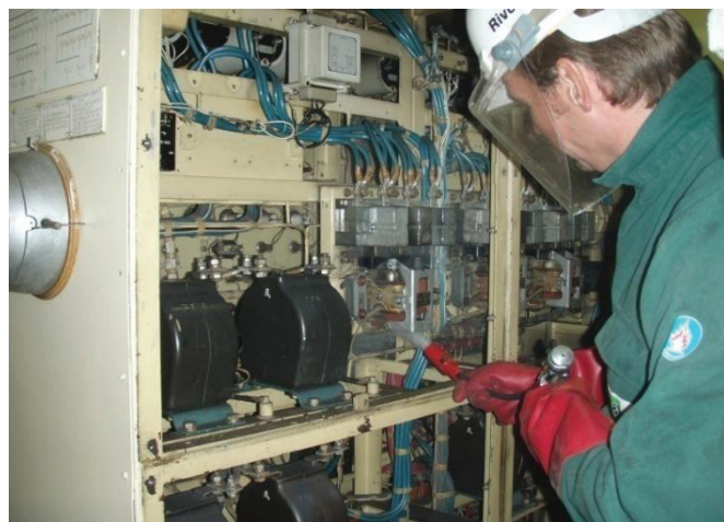
ОЧИСТКА ЩИТА ПОД НАПРЯЖЕНИЕМ 380В СОСТАВОМ FIXEL SEC (SAFETY ELECTROCLEANER) ПРИ ПОМОЩИ БЕЗВОЗДУШНОГО РАСПЫЛИТЕЛЯ
